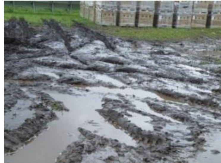
Abb. Bodenstrukturschäden durch Baufahrzeuge
