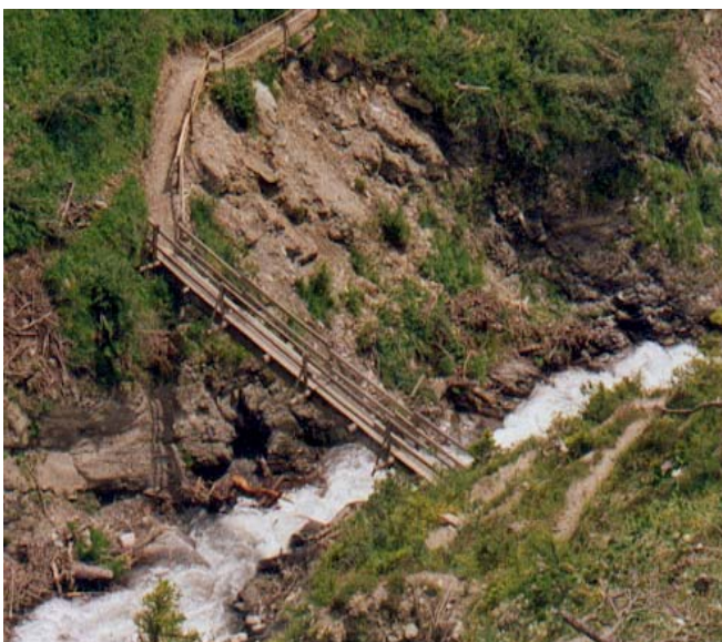
Oft sind bauliche und ingenieurbio-logische Schutzmaßnahmen unumgänglich, um größere Schäden zu verhindern. Photo: Ilson
